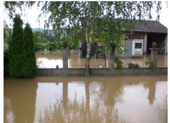
Überschwemmung entlang des Reinersdorferbaches
