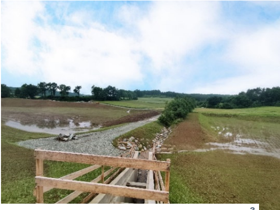
Rückhaltebecken Lapte-Graben – Volumen 84.000 m 3
